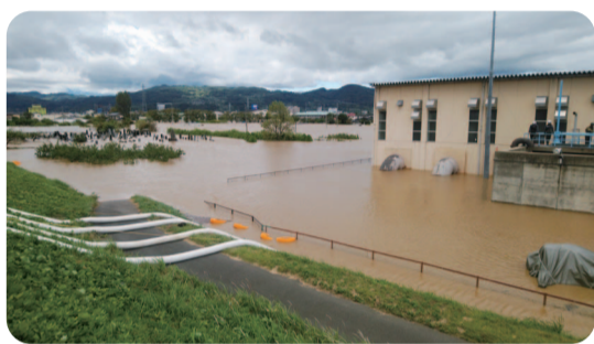
←千曲川堤防越水箇所の被害状況を現地調査で説明。
